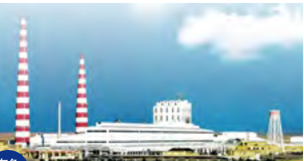
有色金属 中国有色：哈通·阿巴德铜厂项目
